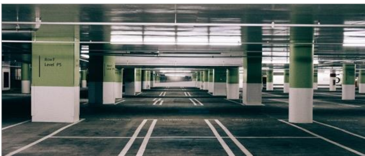
▲半屋外駐車場
